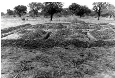
Fondations de l'école
