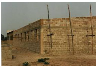
Construction de la deuxième classe
