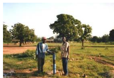
Le forage avant le montage de la pompe
