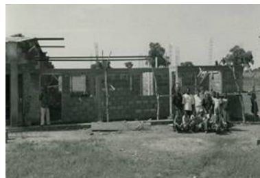
Construction de la première classe
