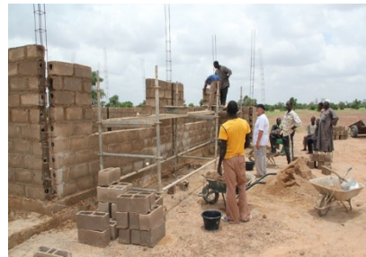
La construction des trois dernières classes
