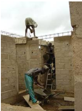
Construction de l'école
