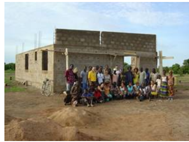
Construction du deuxième logement
