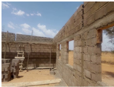
Les murs de la première classe se montent
